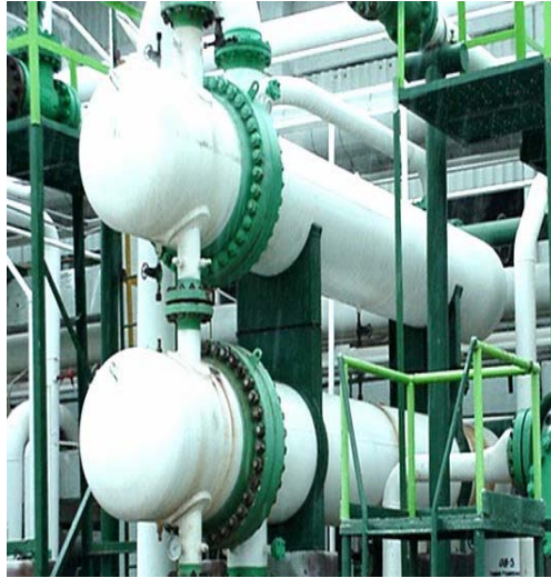
Intercambiador de calor carcaza y tubos
