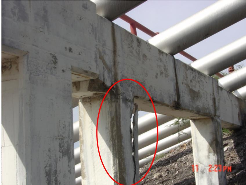
Figura 3.3 Agrietamiento en soportes (pórtico).
