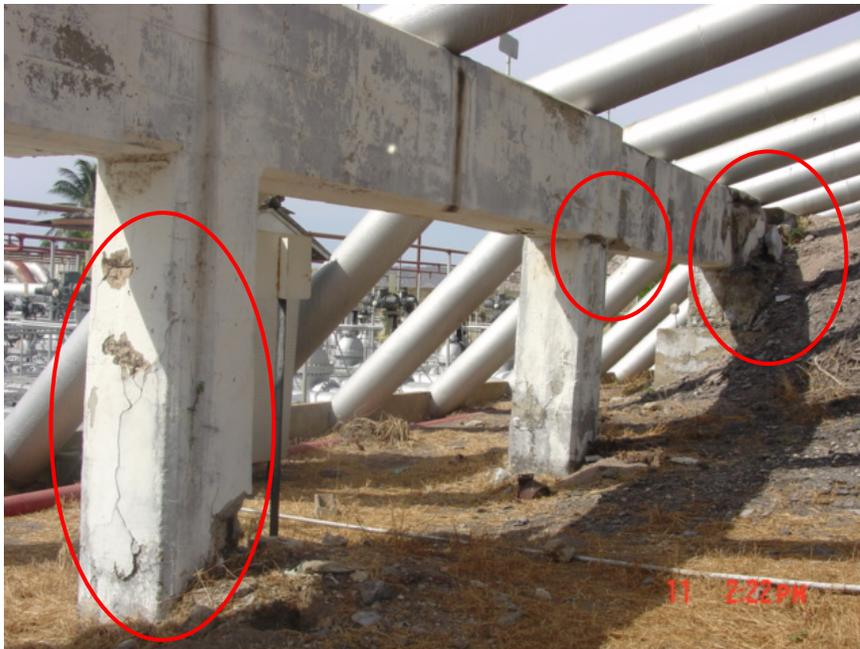
Figura 3.2 Agrietamiento en soportes (pórtico).
