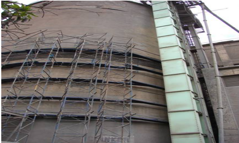
Fig. 3.3 – Elevador de Clínker.
