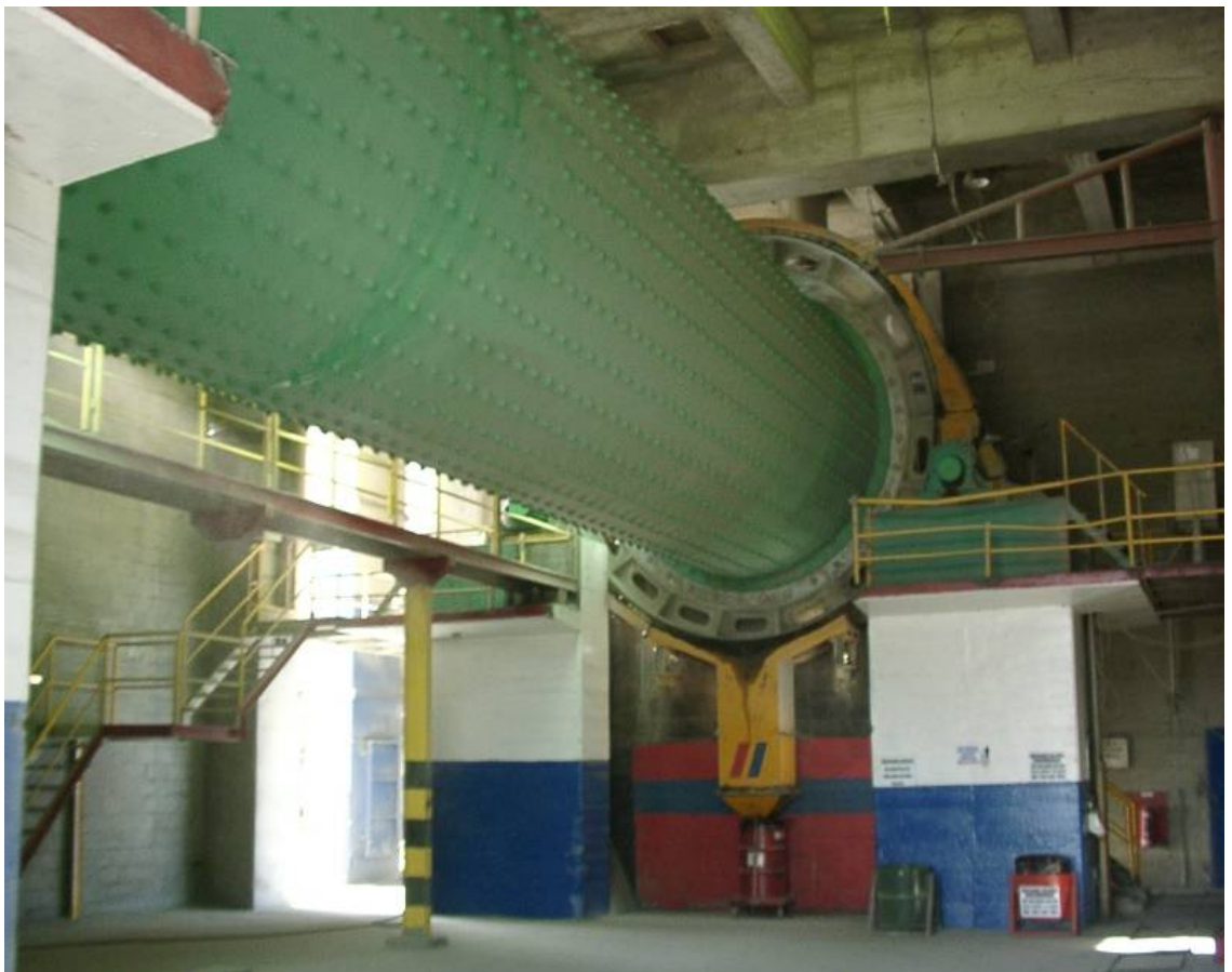
Fig. 1.2 - Molino de bolas, equipo principal del sistema de molienda de cemento Planta Guayana, Julio 2008.
