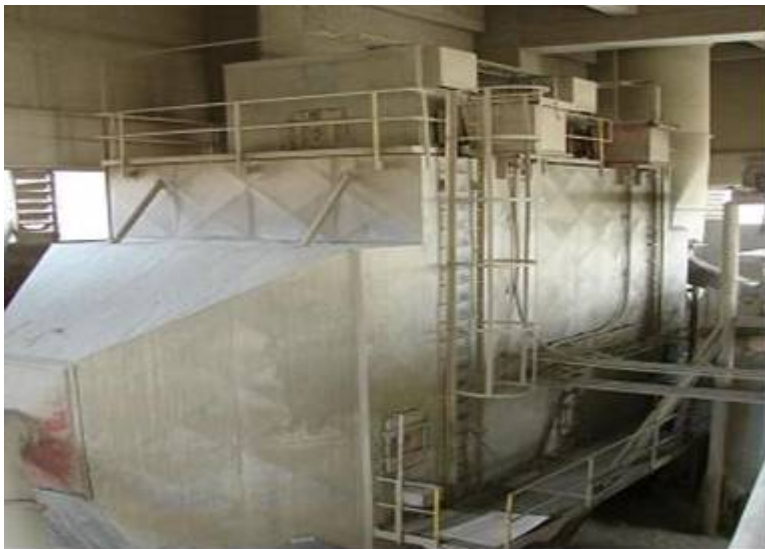
Fig. 3.8 – Electrofiltro o Precipitador electrostático.
