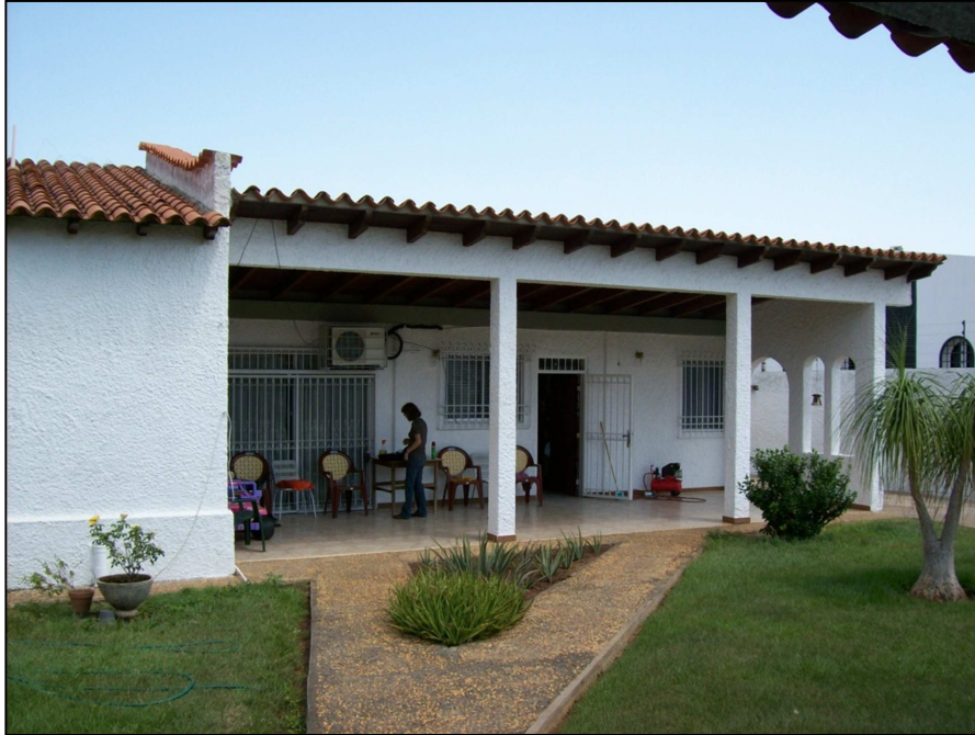
C.2 Fachada posterior.
