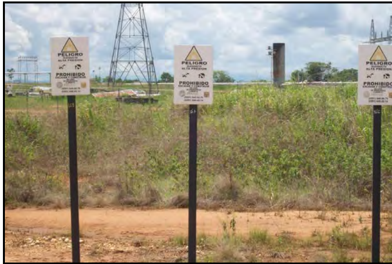
Fig. N° 7. Tubería bajo tierra
