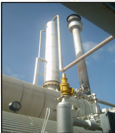
Figura 2.4 Sección condensadora de reflujo y rehervidor
