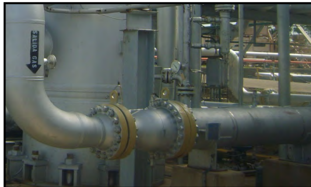
Figura 2.3 Intercambiador de calor gas-glicol
