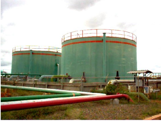
Figura C-9 Tanques Pulmón PITASO
