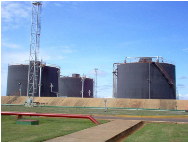
Figura C-10 Tanques Lavadores PTCO
