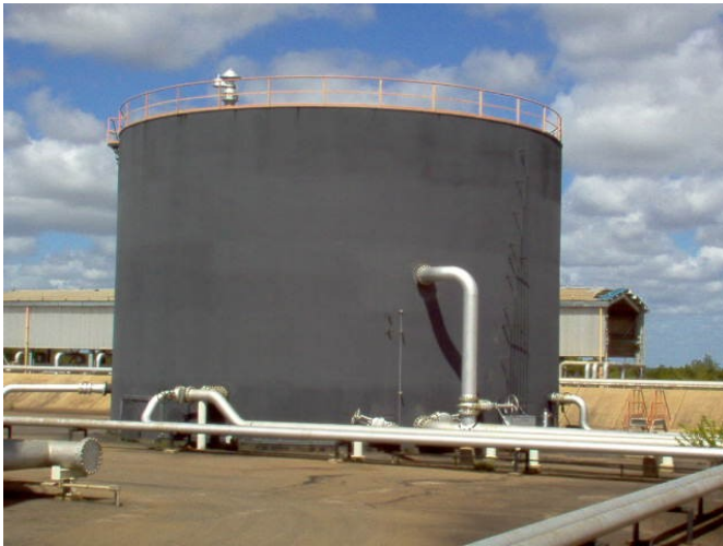
Figura C-8 Tanque Pulmón PTCO
