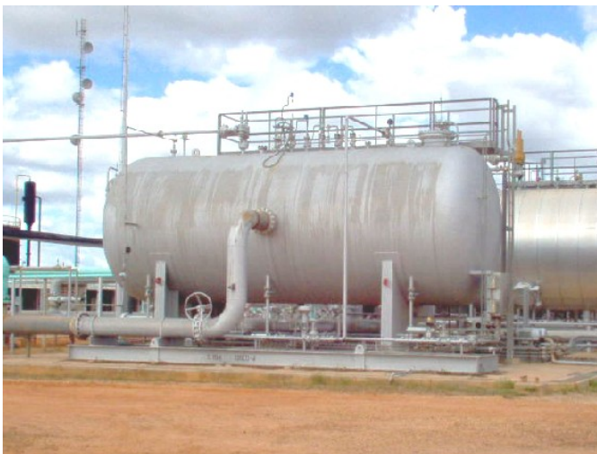
Figura C-4 Tanque Desnatador (Skimmer) ORED-4
