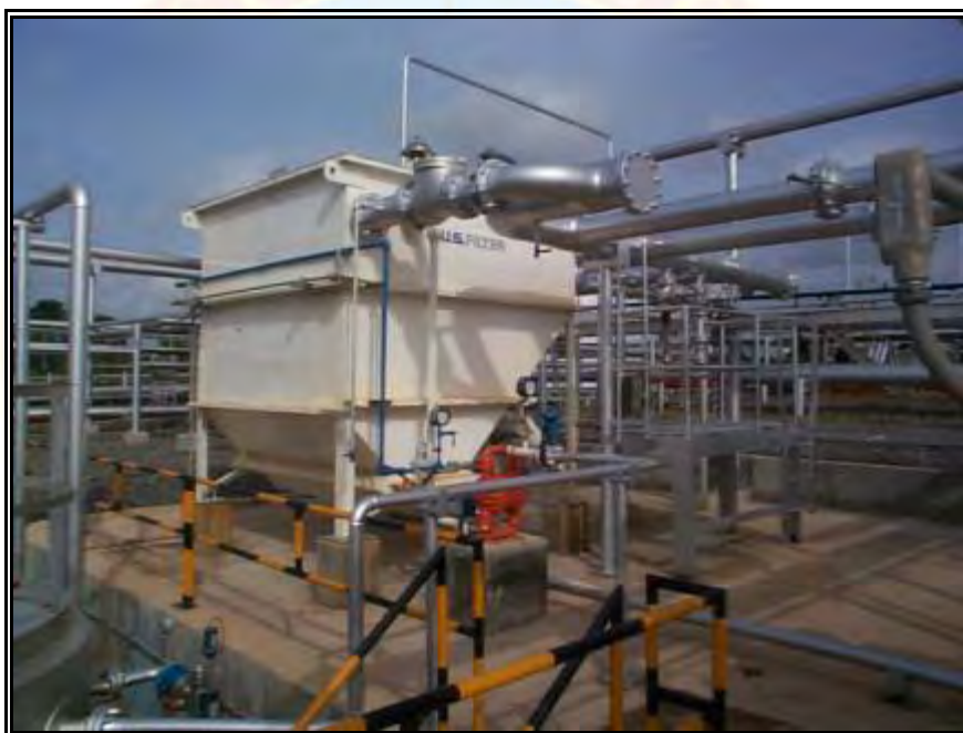
Figura 4.1 Separador de Placas Corrugadas C.P.I. (Fuente: presentación de tecnologías Siemens Water)
