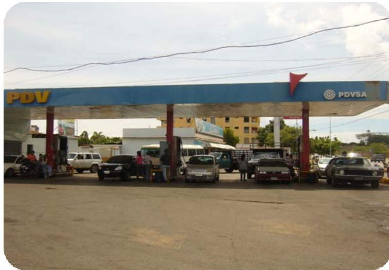
Estación de servicio El Águila
