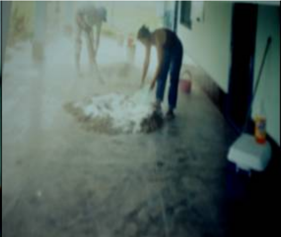
Agregado de cal a la mezcla de los BMN
