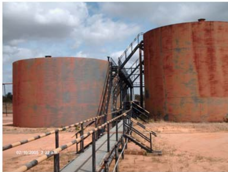
Figura 3.3: Tanque de almacenamiento de crudo BARED-8.
