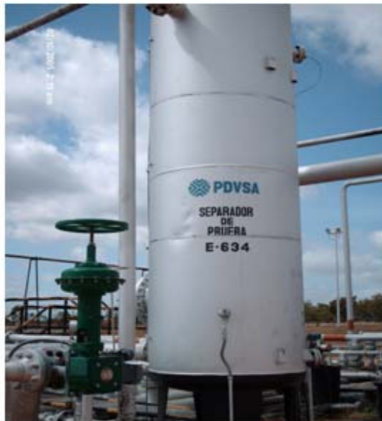
Figura 3.1: Tanque separador BARED-8.
