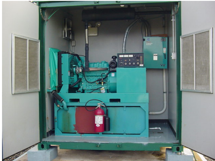
Figura 3.2. Control de Motores de una Estación Radio Base
