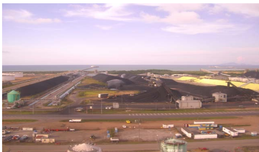
Figura N° 3.6 Pilas de materiales en el patio de sólidos.
