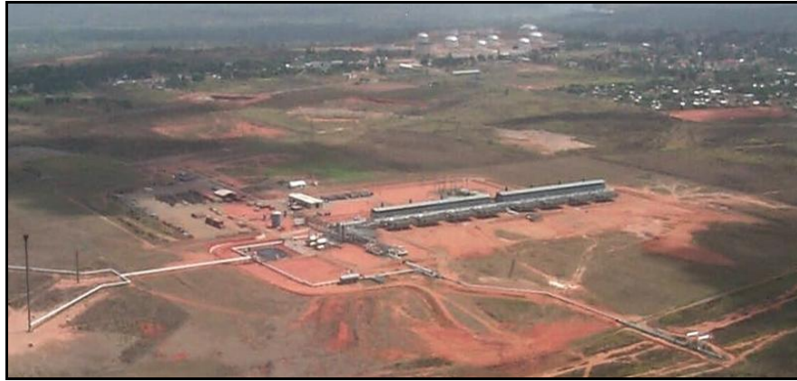
Figura 2.1. Planta de inyección de gas a alta presión (PIGAP II) [1]
