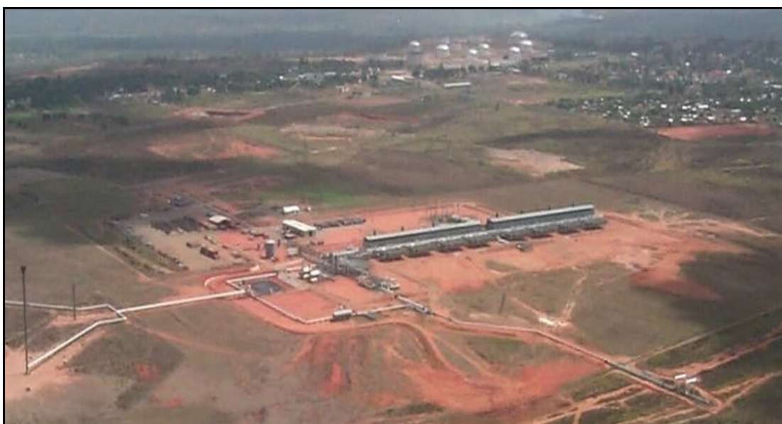
Figura 2.1. Planta de inyección de gas a alta presión ( PIGAPII)
