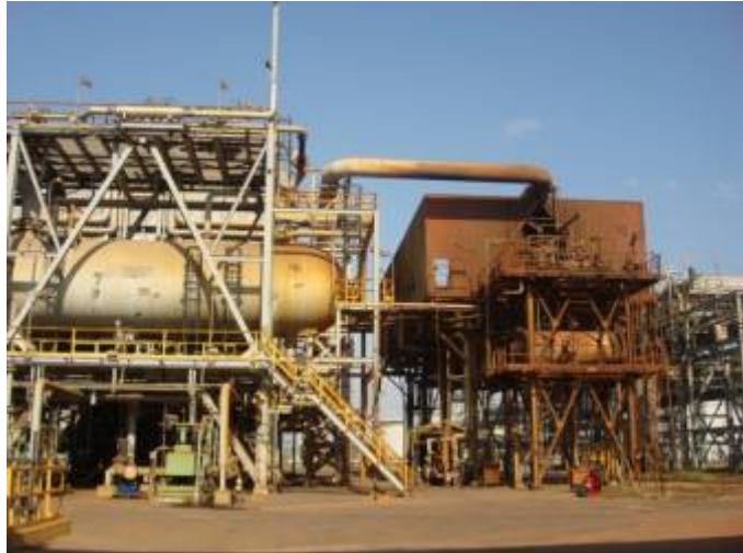
figura 0.3. Imagen del sistema de condensación 02-EA-1008 (derecha)
