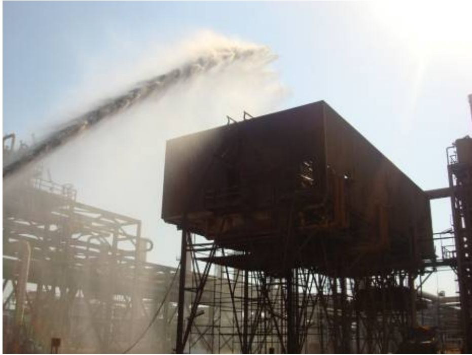
figura 0.1. Medida operacional de rociado de agua contra incendios
