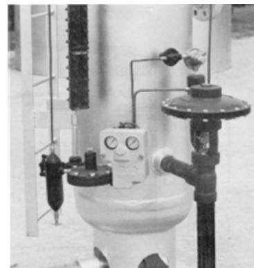
Figura 2.10 Controlador de nivel de liquido sin flotador y válvula de control tipo diafragma. [7]
