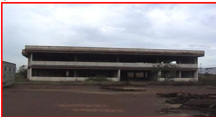
Figura 1.1. Edificio de operaciones, parcialmente construido en el año 1989.
