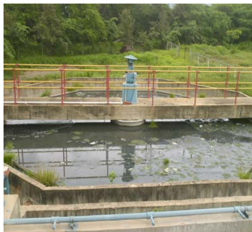
Figura 4.5 Estanque de sedimentacion
