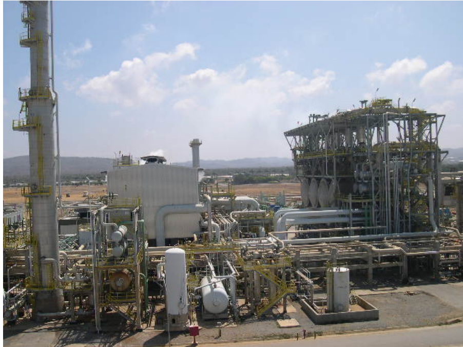
Figura 2.5. Unidad de deshidrogenación 200 (Fuente propia)
