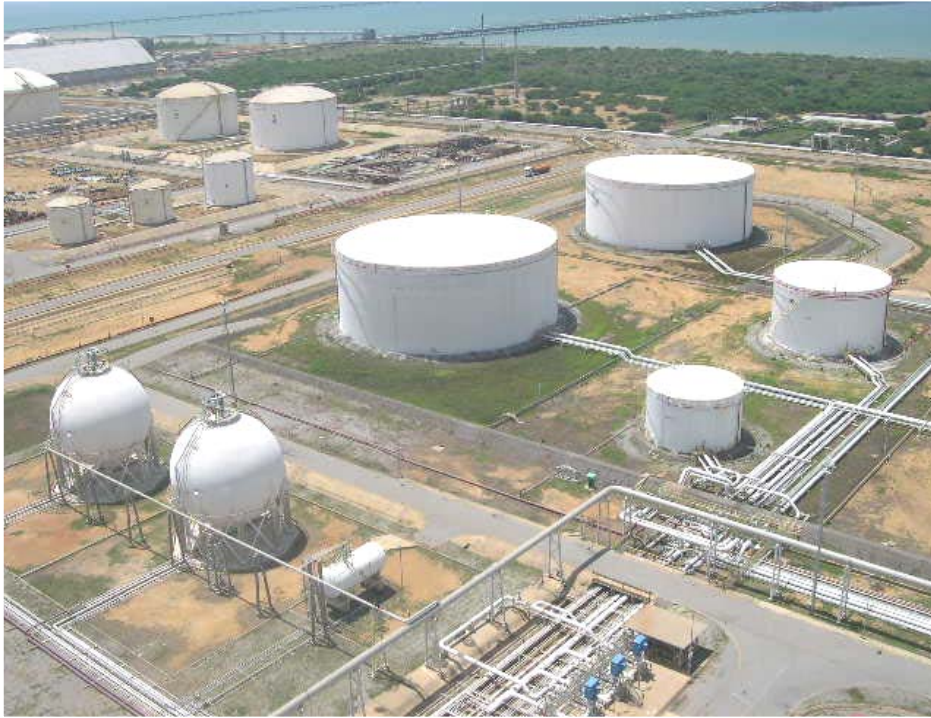
Figura 2.8. Unidad de almacenamiento 800 (Fuente propia)
