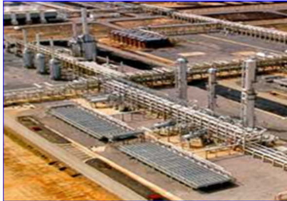
Figura 2.20 Tren de Fraccionamiento de LGN.
