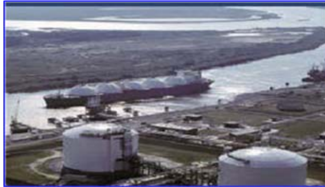
Figura 2.10 Terminal de recepción del Gas natural.
