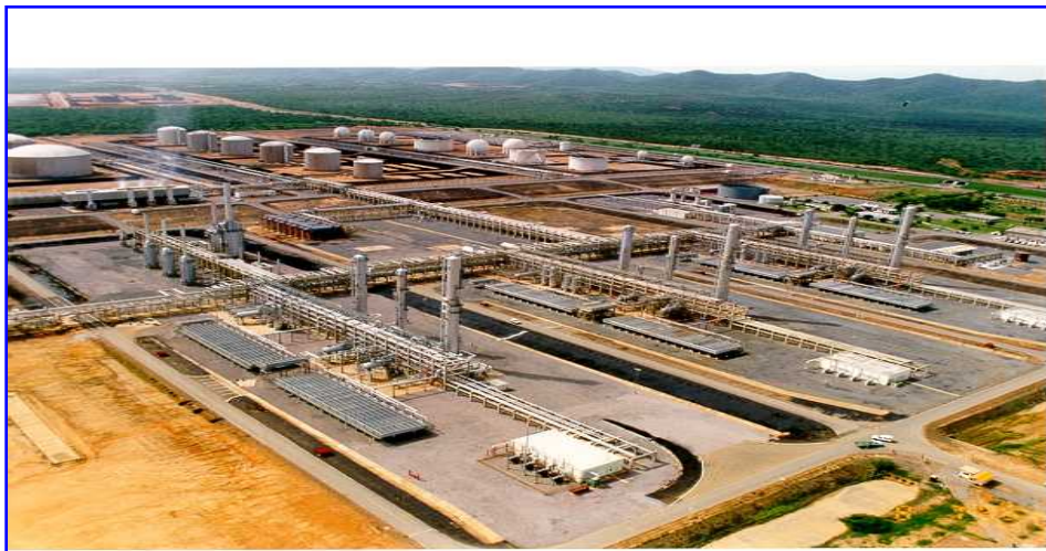
Figura 2.15 Fotografía aérea de la Planta de Fraccionamiento y Despacho JOSE.
