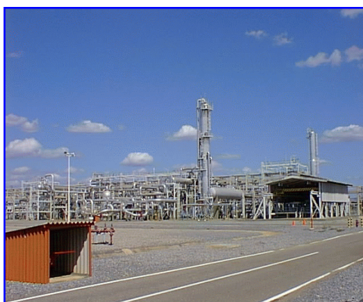
Figura 2.14 Fotografía de la Planta de Extracción San Joaquín
