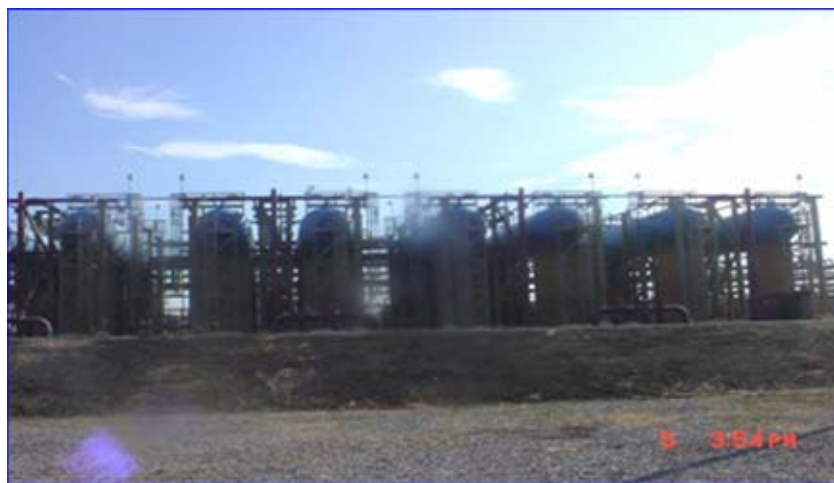
Figura 2.16 Fotografía del sistema de almacenamiento de LGN (balas).
