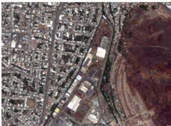
Figura 1.2 Vista aérea planta SOLTUCA [3].
