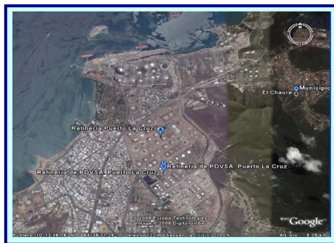
Figura 1.1. Vista completa Refinería Puerto La Cruz.
