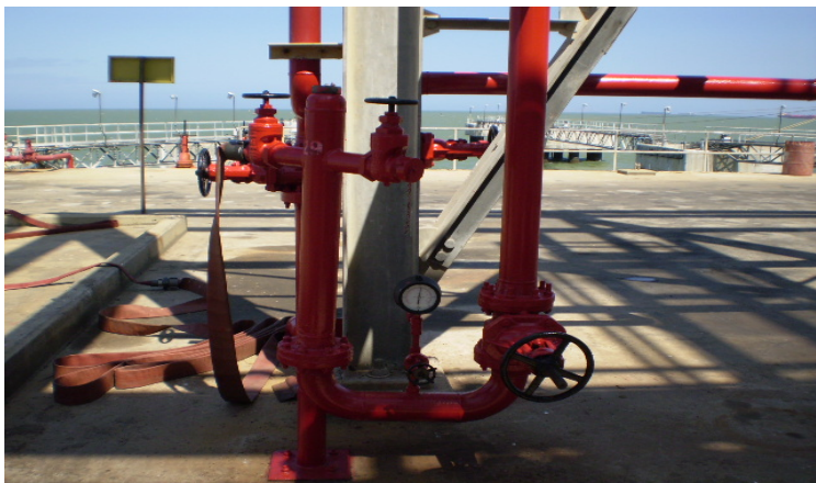
Figura 2. Detectores de incendios
