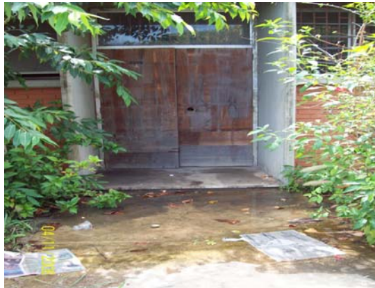
Figura 4.3 parte externa del departamento. Fuente: elaboración propia.
