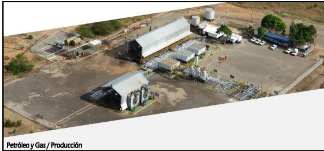
Figura 18. Vista aérea Planta Compresora Soto
