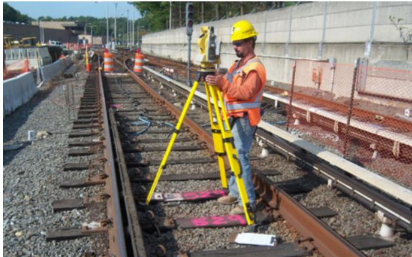
Figura 3.1: Medición topográfica en las adyacencias de la vía de un ferrocarril
