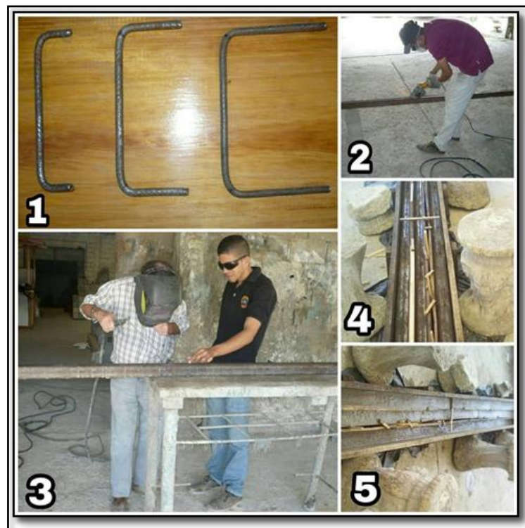
Figura 5. Proceso de Construcción de vigas mixtas: 1) Conectores de corte. 2) Limpieza de corrosión con esmeril a la parte superior del perfil kариña. 3) Soldadura de conectores al perfil 4) Encofrado, 5) Vaciado de las vigas. Fuente: Autores.
