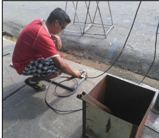
Figura 13. Soldado de la estructura.
