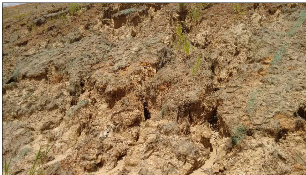
Figura 30. Talud de la zona Oeste de MPJ-07.
