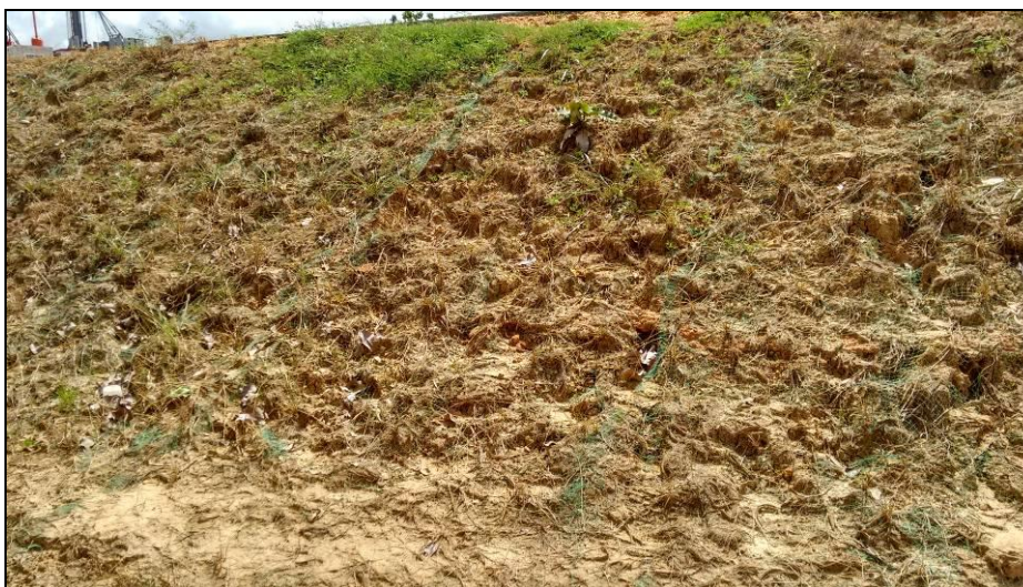
Figura 22. Talud de la zona Este de MPJ-06
