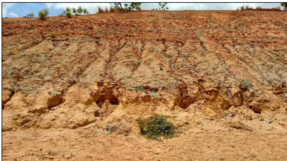
Figura 26. Talud de la zona Este de MPJ-07.
