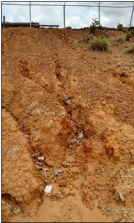
Figura 28. Talud de la zona Noroeste de MPJ-07.
