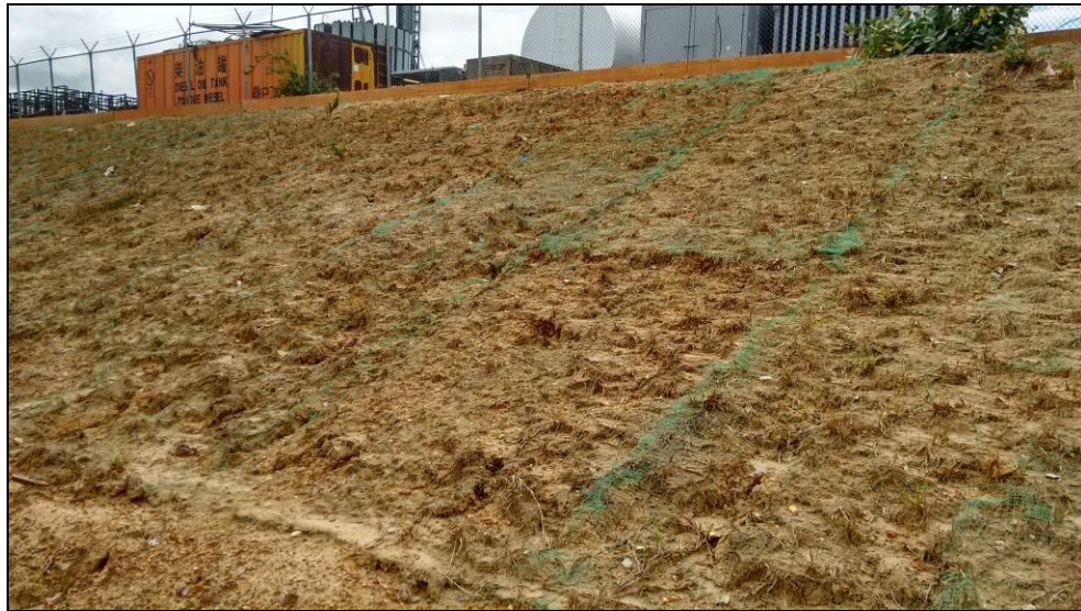
Figura 23. Talud de la zona Oeste de MPJ-06
