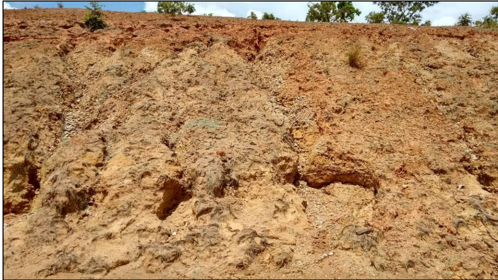
Figura 27. Talud de la zona Sur de MPJ-07.
