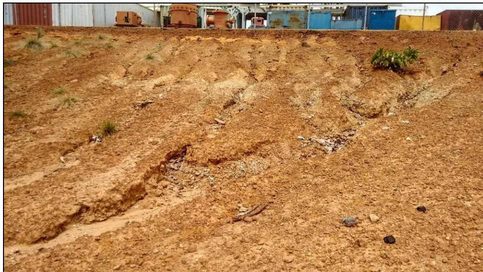
Figura 29. Talud de la zona Noreste de MPJ-07.
