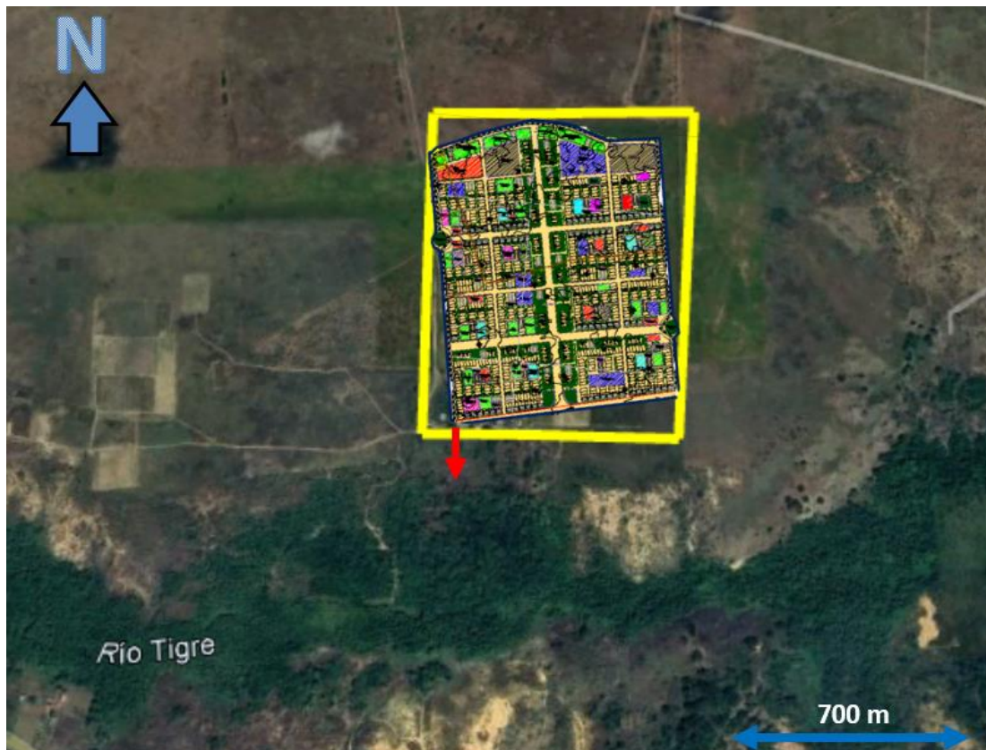
Figura 5.7 Punto de drenaje del urbanismo hacia el sur (flecha roja).
