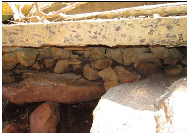
Figura 5.15 Vista del tope de la cimentación bajo el plinto del dique (Hernández, 2022).
