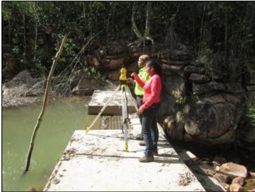
Figura 5.1 Trabajo topográfico en el dique Venezuela Heroica
