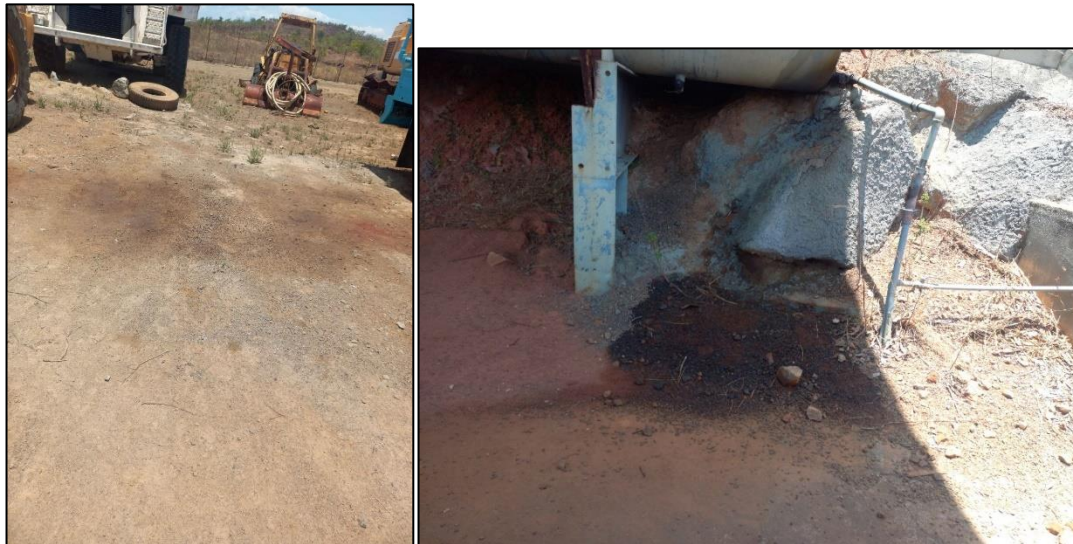
Figura 5.2 Fugas de combustible en tanque de almacenamiento y manchas de combustible por falta de mantenimiento
