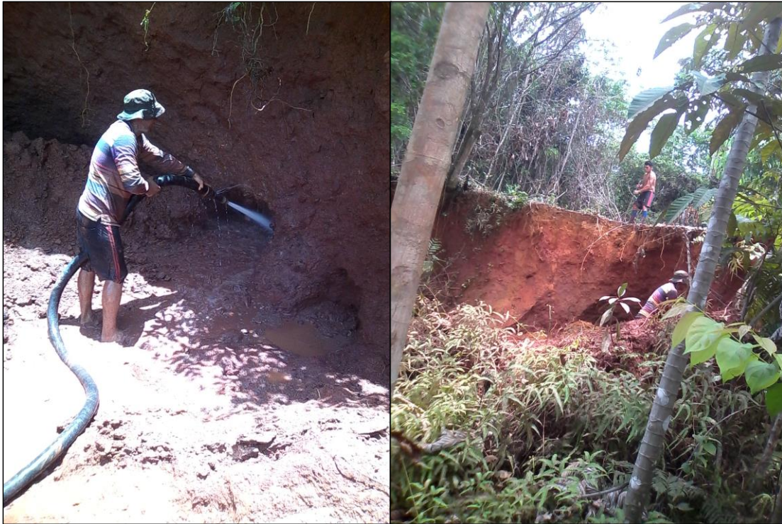
Figura 5.11 Remoción de la capa de suelo para la extracción del mineral
