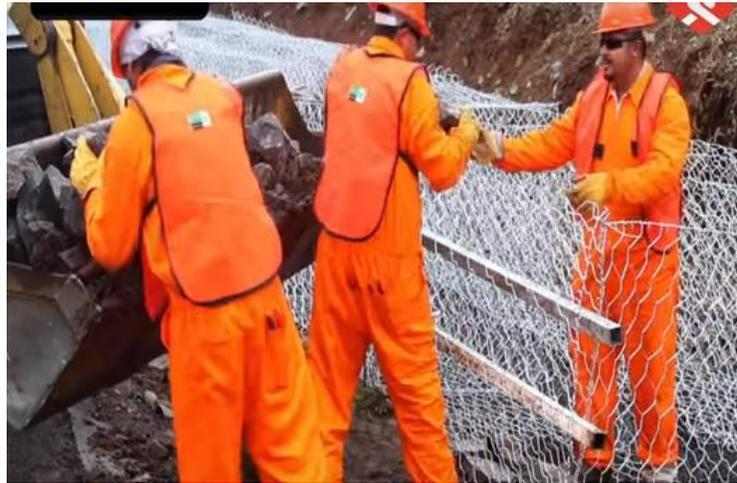
Figura 6.4 Llenado manual del gavión con rocas de 4 a 6 pulgadas de diámetro y peso específico de  $2.0 \text{ Tm/m}^3$  (LEMAC, 2019).
