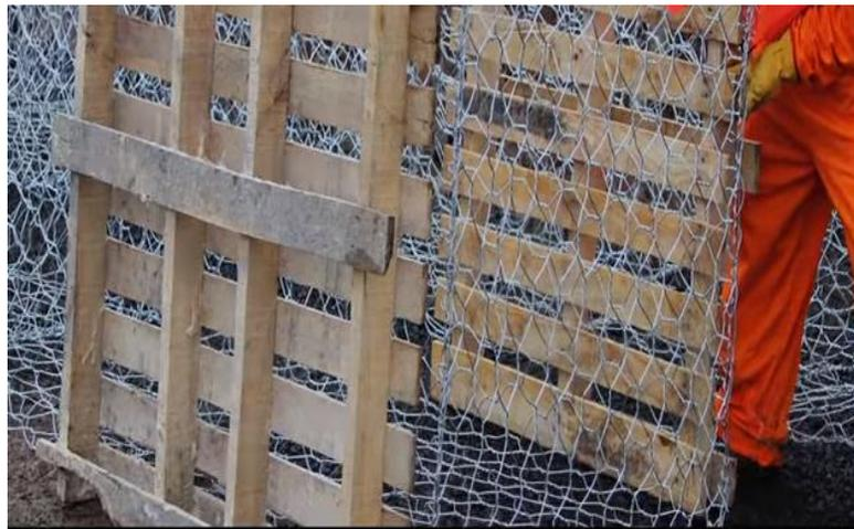
Figura 6.3 Colocación de cimbras para dar rigidez a la malla del gavión durante su llenado (LEMAC, 2019).
