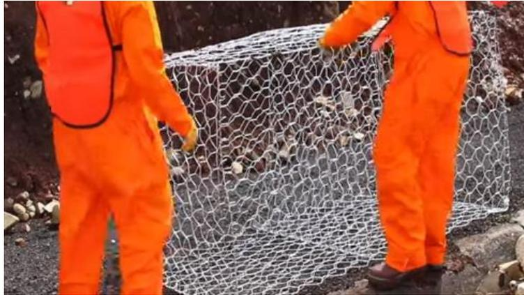
Figura 6.2 Armado de malla de gaviones (LEMAC, 2019).
