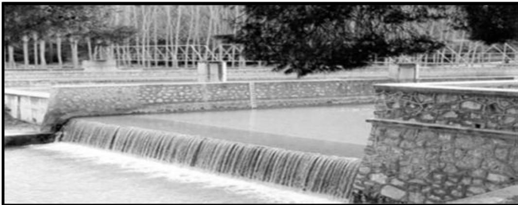
Figura. 3.2 Vertedero fabricado con mampostería sobre río Segura, Murcia España.
