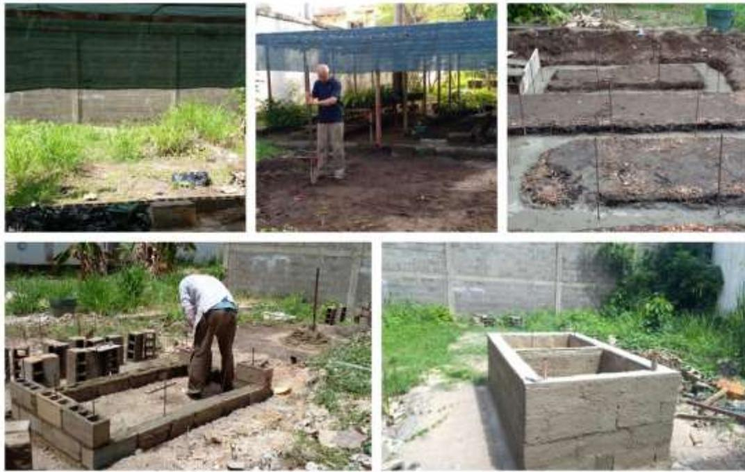
**Figura 16. Construcción de Lombricarios**
