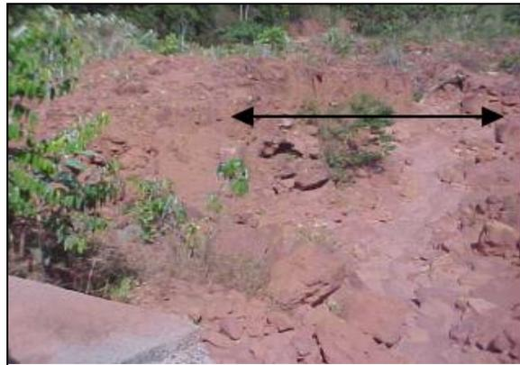
Figura 5.15 Socavación Lateral. Caño El Chorro.
