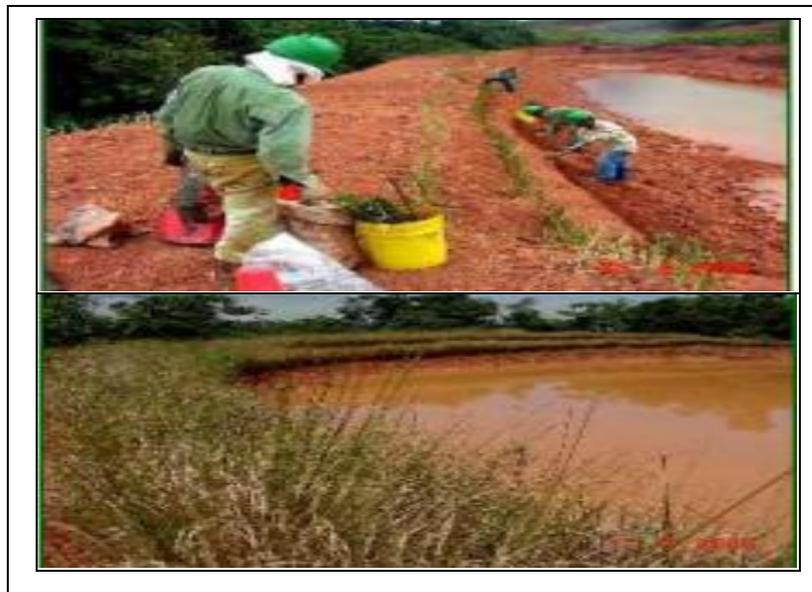
Figura 5.18 Siembra de Vetiver en lagunas de sedimentación.
