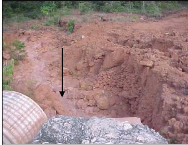
Figura 5.16 Socavación de fondo. Caño El Chorro.
