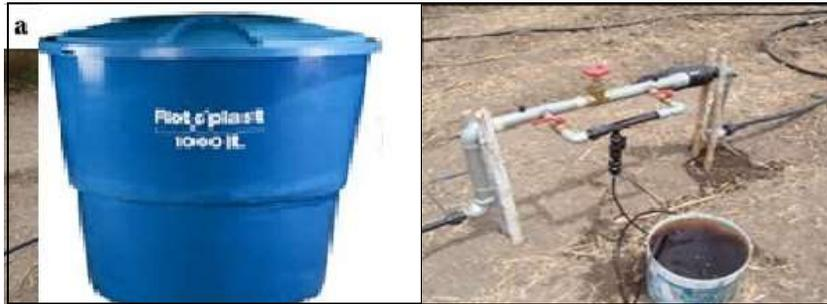
**Figura 8 (a) Tanque de almacenamiento de agua; (b) Cabezal de control constituido por la llave principal, filtro y Venturi;**
