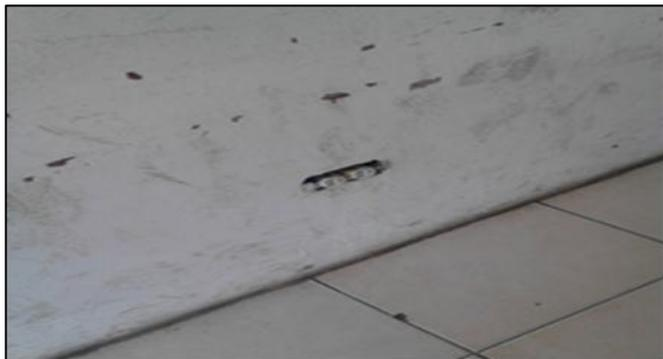
Figura 5.7 Conector de corriente dañado en el aula 10 (Sulbaran, D 2015)
