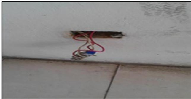
Figura 5.5 Conector de corriente dañado en el aula 8 (Sulbaran, D 2015)
