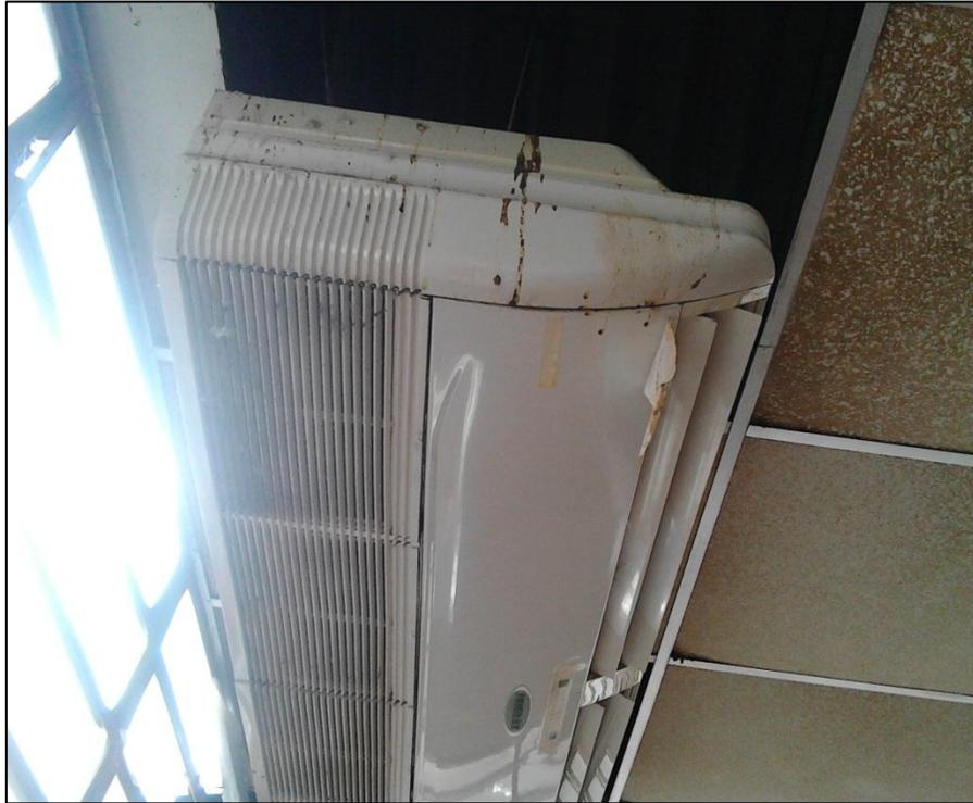
Figura B.15 Presencia de moho en equipo de aire acondicionado
