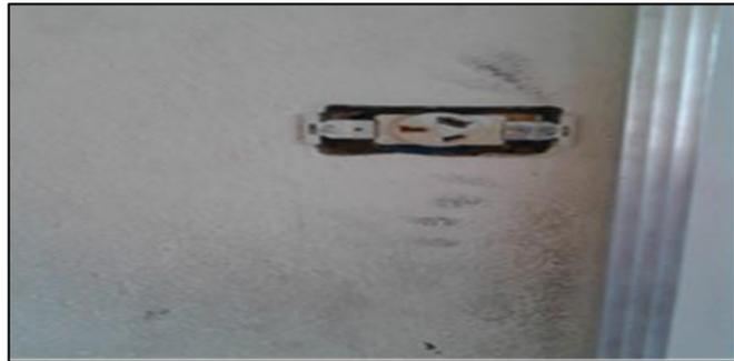
Figura 5.4 Conector de corriente dañado en el aula 8 (Sulbaran, D 2015)
