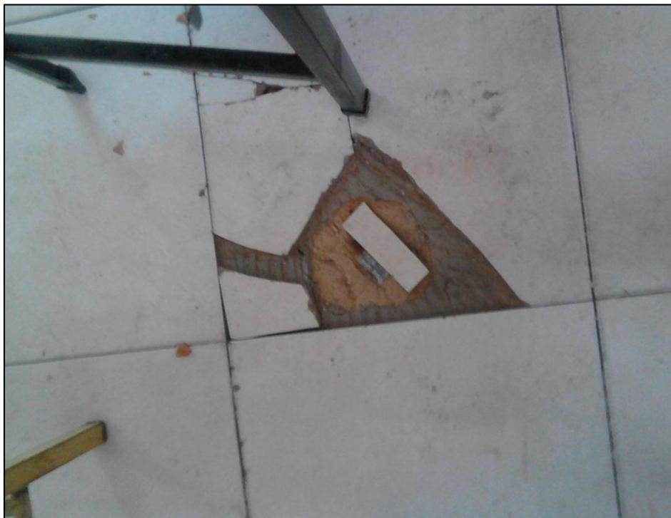
Figura B.17 Presencia de Moho en el piso
