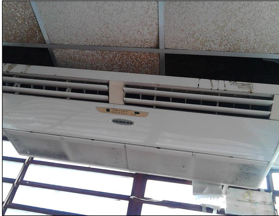
Figura B.18 Presencia de excremento de aves de palomas en el equipo de aire acondicionado
