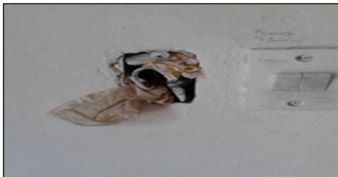
Figura 5.6 Conector de corriente dañado en el aula 9 (Sulbaran, D 2015)
