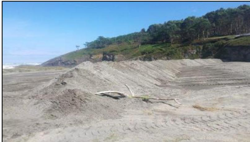
Figura 5.13 Ejemplo de construcción de un dique para acopio de arena dragada lo cual implica deforestación y remoción total de la capa vegetal (Dredging International, 2018).
