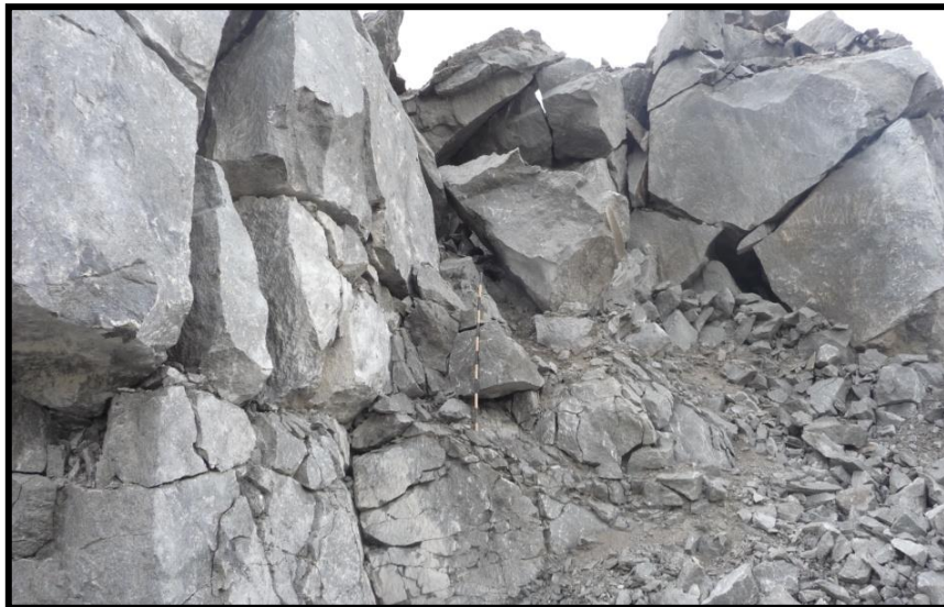
Figura 5.2 Vista en detalle del grado de fracturamiento del macizo.
