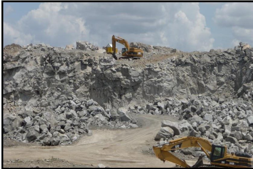
Figura 5.1 Panorámica del frente de explotación exhibiendo las diaclasas en el macizo
