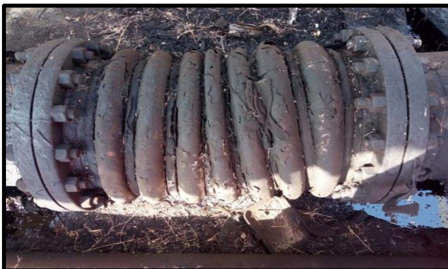
**Figura A8** Condición actual de las juntas de expansión, se puede ver el desgaste esta junta se encuentra ubicada en las adyacencias del tanque de almacenamiento atmosférico 250X4.
