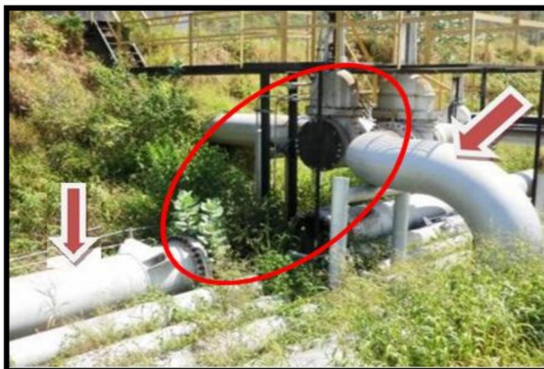
**Figura A1** Múltiple de distribución hacia tanque 250x4. Se indican en flecha el cabezal de  $\text{Ø}=34''$  (izquierda), la línea de  $\text{Ø}=30''$  (cabezal de  $\text{Ø}=30''$ ) a la derecha y dentro del círculo el ramal de  $\text{Ø}=30''$  (no observado en sitio) que conectaría al cabezal de  $\text{Ø}=34''$  con la línea de  $\text{Ø}=30''$  del tanque 250x4.
