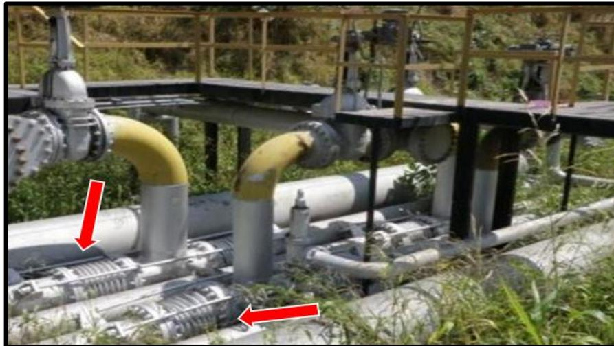
**Figura A3** Vista del tendido de tuberías de Ø=12\", Ø=14\", Ø=16\" y Ø=18\" donde se muestran las juntas de expansión existentes en el múltiple de distribución hacia el tanque 250x4.
