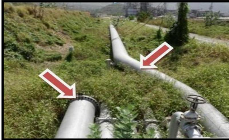
**Figura A9** Cabezal de  $\text{Ø}=30''$  desde tanques 250x4/5 hacia las plantas de la refinera.
