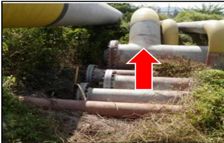
**Figura A10** Cabezales Principales de residual de  $\text{Ø}=12''$ ,  $\text{Ø}=14''$ ,  $\text{Ø}=16''$ ,  $\text{Ø}=18''$  y  $\text{Ø}=34''$ . La flecha señala el punto de conexión del cabezal principal de 34" con el cabezal de 34" de los tanques 250X4/5/6, punto que corresponde al límite de batería del alcance del estudio de flexibilidad.
