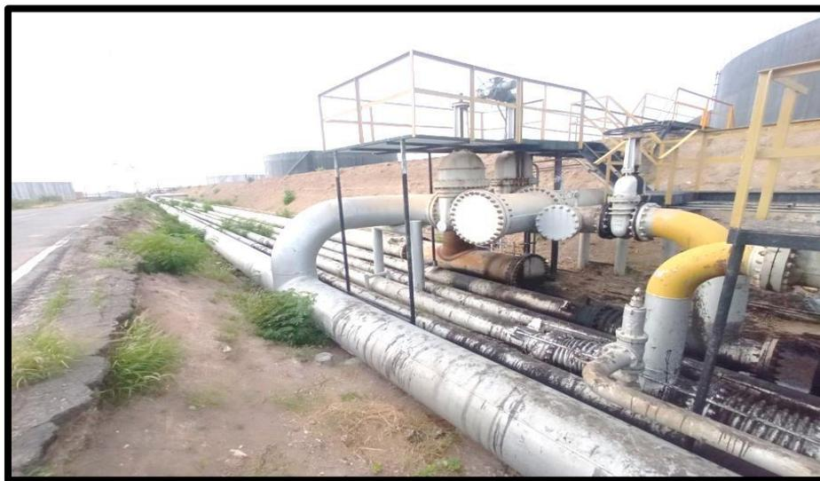
**Figura A4 Vista en la trinchera de las líneas cabezales que reciben y distribuyen residual correspondiente a los tanques de almacenamiento atmosférico 250X4,250X5 y 250X6. Indicado con flecha los cabezales de  $\text{Ø}=30''$  y  $\text{Ø}=34''$  que fueron evaluados y dentro del círculo las líneas que no forman parte del alcance de este estudio**
