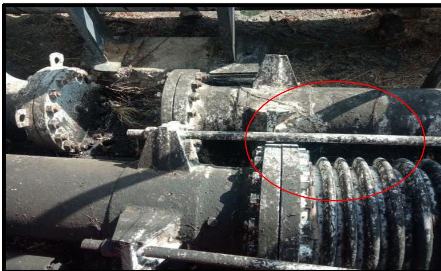
**Figura A7** Condición actual de las juntas de expansión, ubicadas las adyacencias del tanque de almacenamiento atmosférico 250X4.
