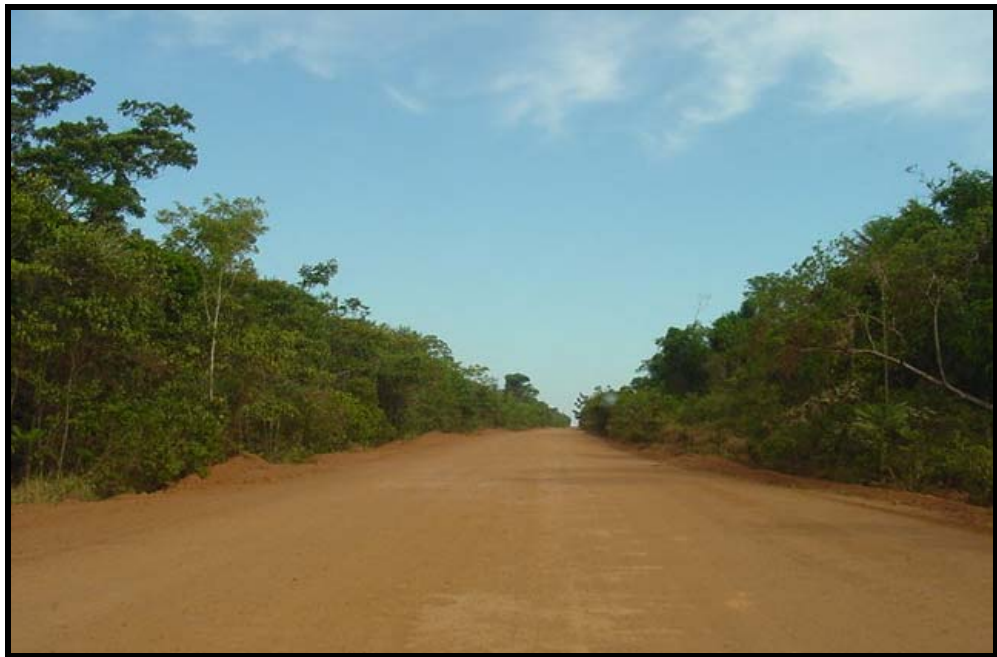
Fotografía. 2.1. Carretera engrazonada que da acceso a la Mina
