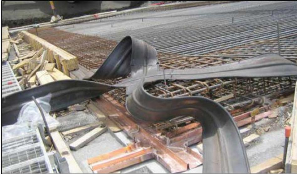
Figura 3.11 Detalle de una junta de una pantalla de concreto (Sandoval, W. 2019).
