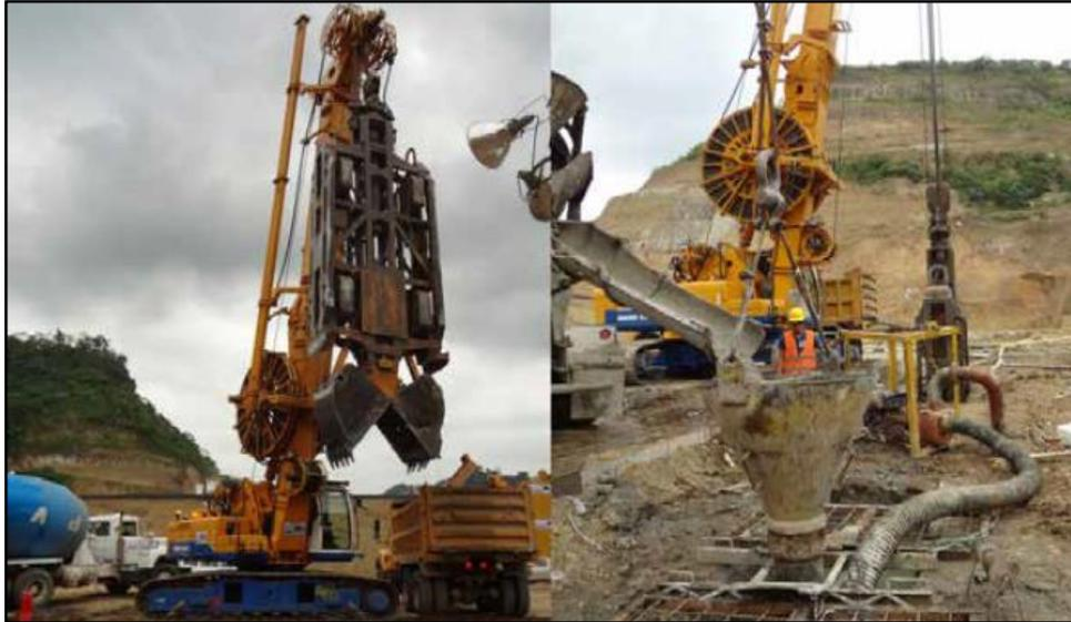
Figura 3.13 Proceso de construcción de una pantalla de concreto plástico (Sandoval, W. 2019).
