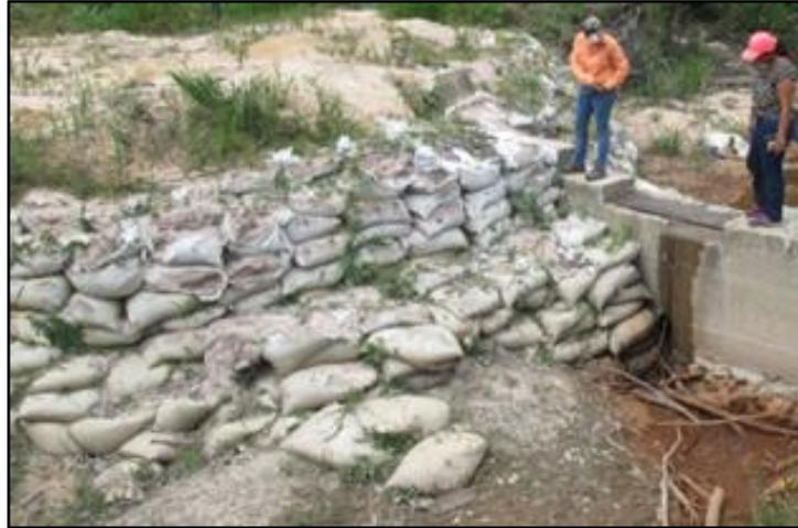
Figura 5.3 Aspecto del estribo izquierdo de tierra y parte del monolito de concreto del dique Wará I.
