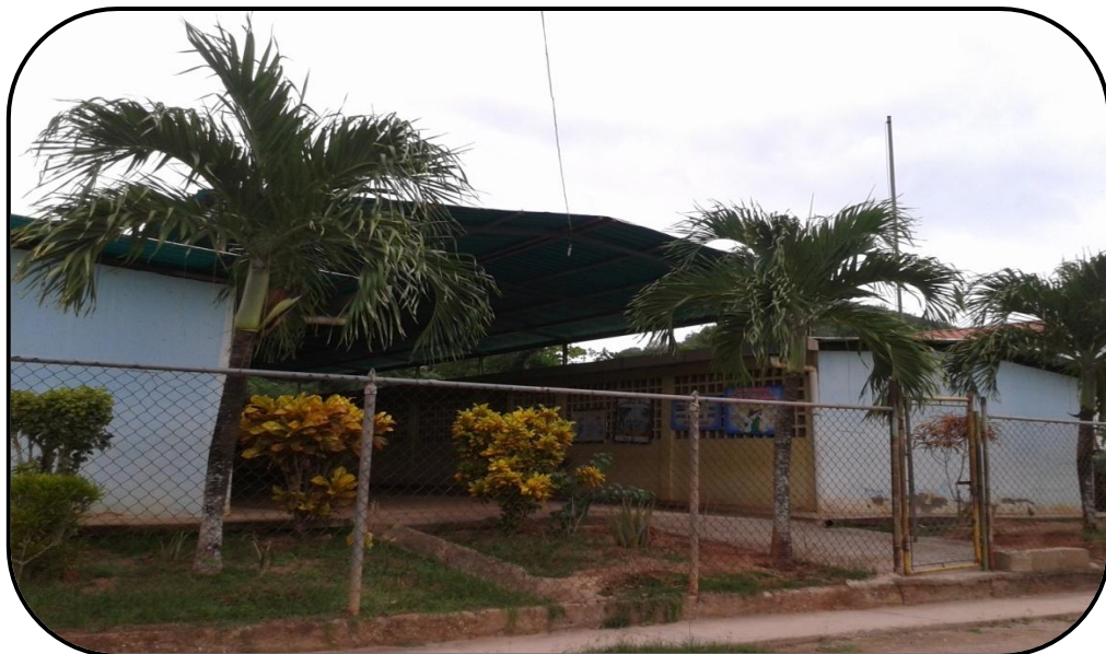
INSTALACIONES DE LA U.E.B. "POZO COLORADO I"
