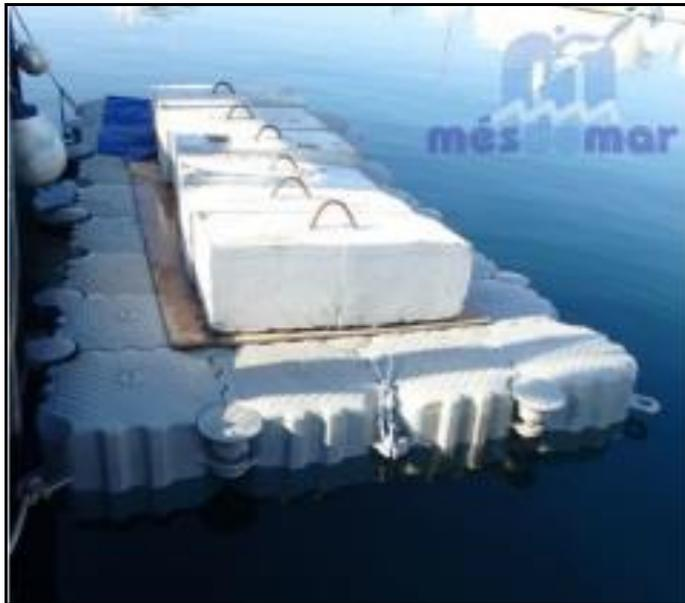
Figura 5.8 Bloques de concreto para anclaje de las boyas (INCm 2014).
