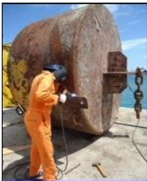
Figura 5.6 Trabajo de soldadura en cubierta a la boya (Gutiérrez y Nogueza, 2019).
