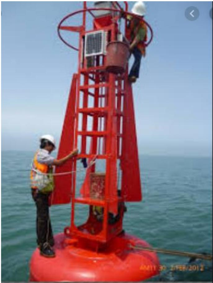
Figura 5.9 Mantenimiento de sistema de iluminación a bordo de la boya (INC,2014)
