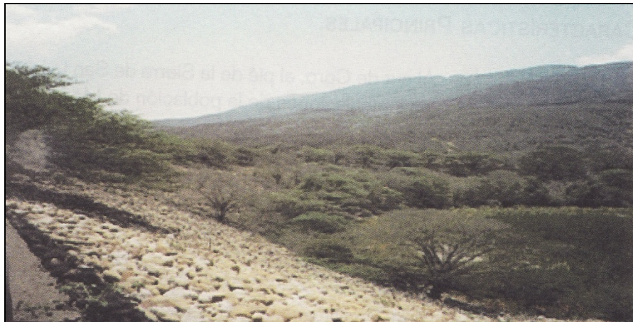
Figura N° 2.11 Vista del talud aguas arriba de la presa Siburua
