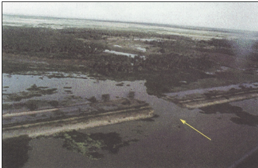
Figura N° 2.23 Presa tocuyo de la costa. Vista área de la brecha.
