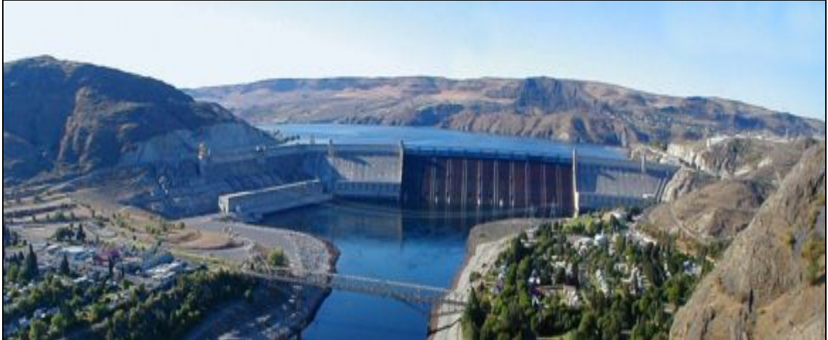
Figura Nº 2.7 Vista panorámica de la presa Grand Coulee, mirando al sureste. La central eléctrica número tres, que se encuentra abajo a la izquierda de la presa, es lo bastante grande como para albergar cinco campos de fútbol.
