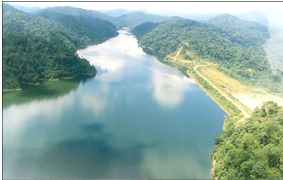
Figura N° 2.15. Presa El Guapo, antes de la falla.
