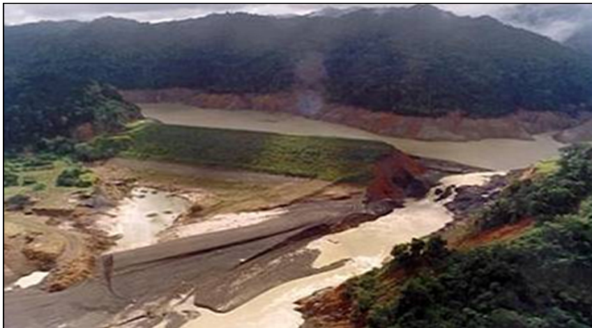
Figura N° 2.21. Presa El Guapo, después de la falla.
