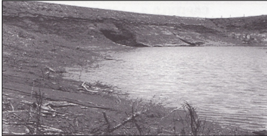
Figura N° 2.12. Presa Las Tinas, túnel en el terraplén
