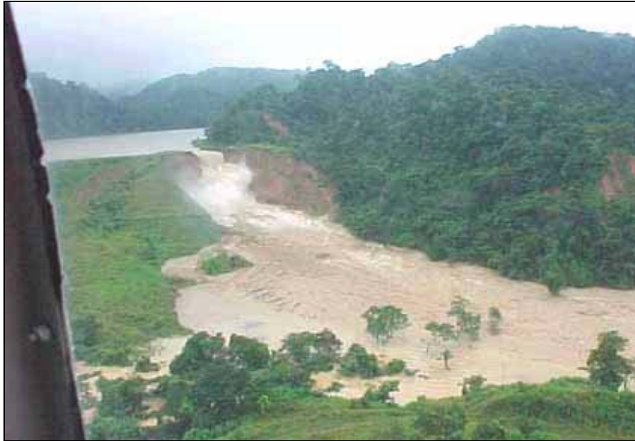
Figura Nº 2.19. El cauce aguas abajo de la presa se convirtió en un inmenso río.
