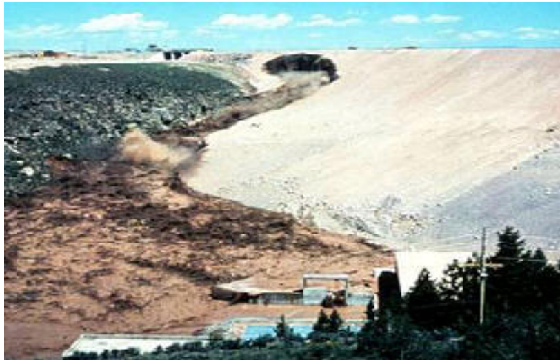
Figura Nº 2.8 Vista noroeste hacia el estribo derecho Represa el Tetón. El hueco en la cara de la presa crece hacia arriba
