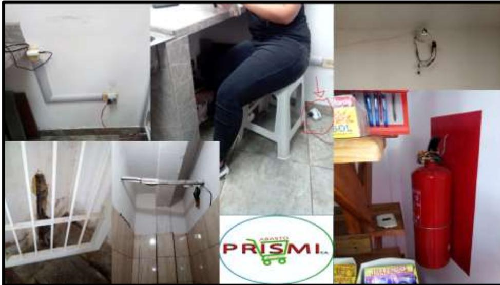
Figura 5.2 Extintor está poco accesible. Cableado en ubicación inadecuada
