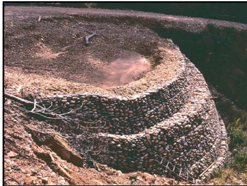
Figura 3.21 Muro de gaviones (Suarez, 2001)
