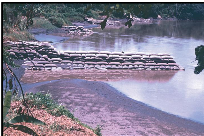
Figura 5.30 Ejemplo de espigones en un río
