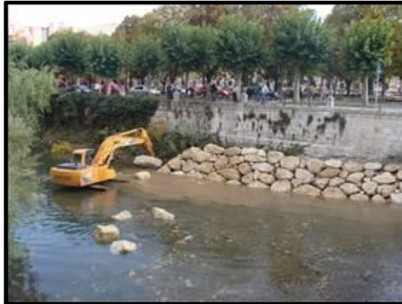
Figura 3.19 Protección de orilla con enrocado Riprap (Cardenas, 2012).
